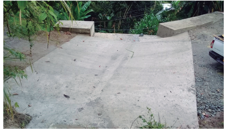
Figura 7. Batea tipo en concreto reforzado
