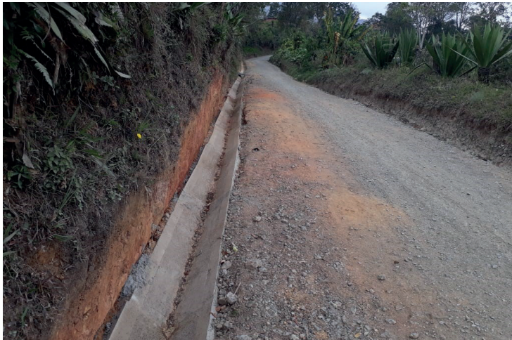
Figura 4. Tipo de cuneta revestida en concreto
