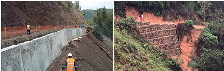
Figura 9. A la izquierda, muro de contención en concreto reforzado; a la derecha, muro de contención en gavión
