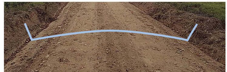
Figura 3. Descripción curva de bombeo sobre la calzada
